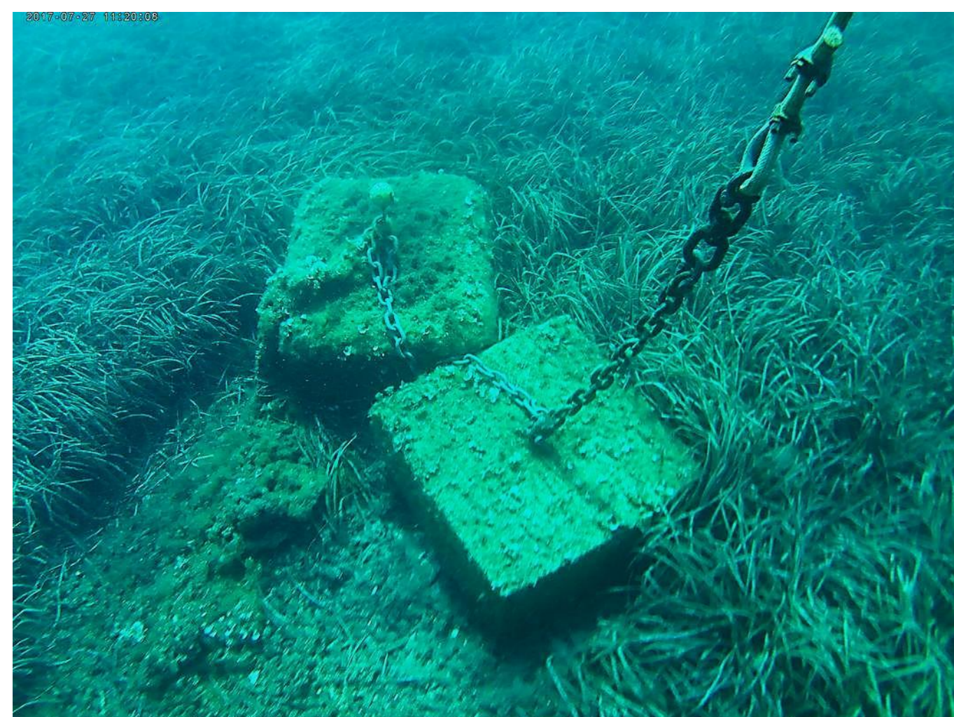
Figura 6: Muertos de fondeo localizados sobre posidonia.
